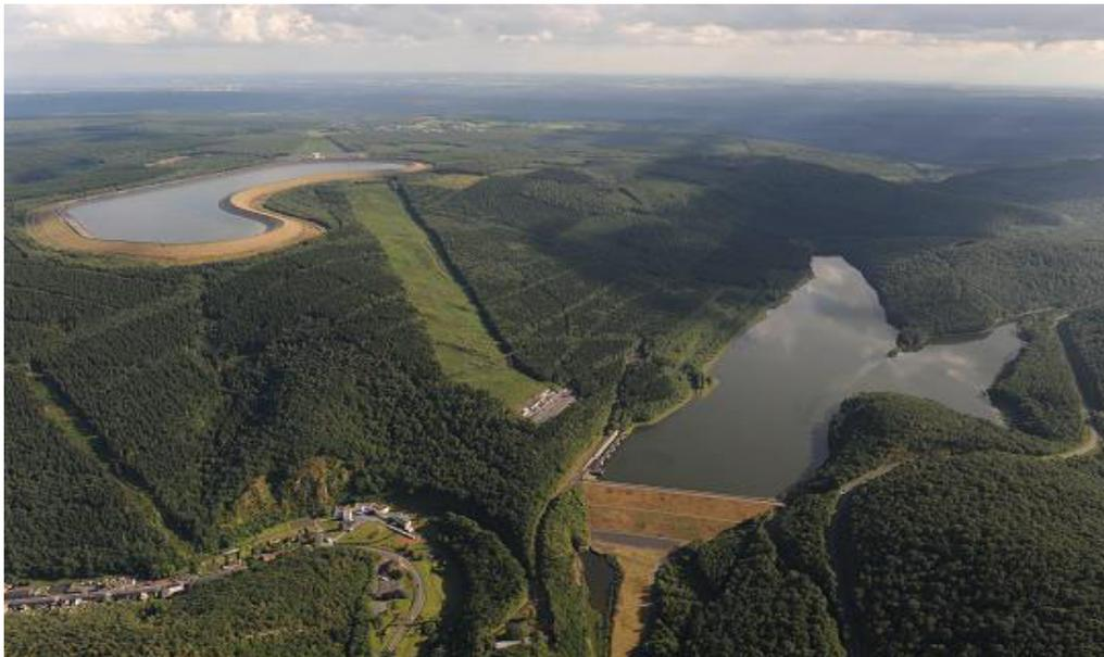
*Station de transfert d'énergie par pompage de Revin (Ardennes): dénivelée 200 m, puissance maxi 720 MW, capacité maximale de stockage 3,6 GWh, pertes d'énergie: 25 %. Coût d'investissement approximatif : 500 millions d'euros actuels.*
